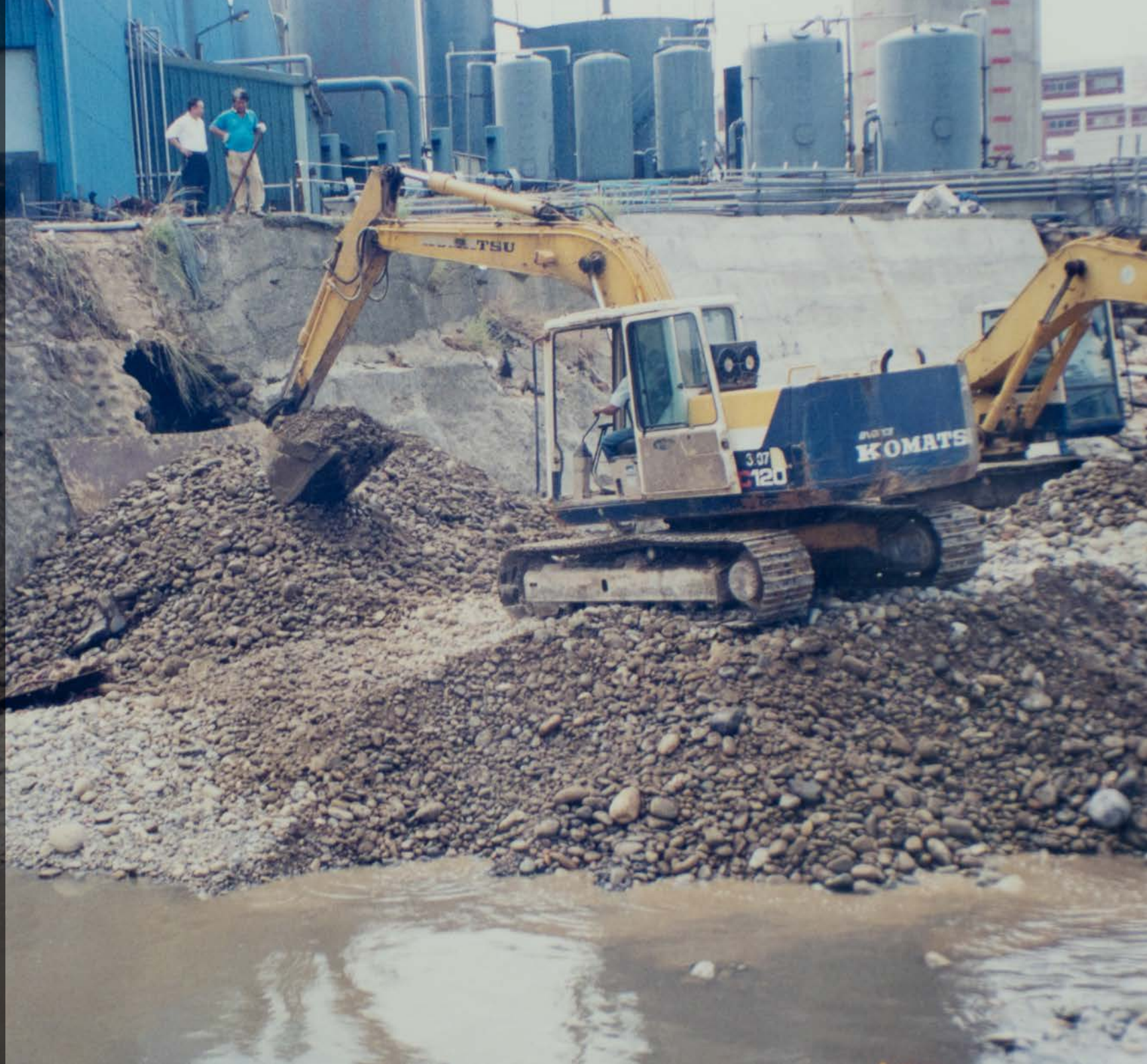
民國 90 年納莉風災造成頂立染整廠淹水，後進行填河造地工程
